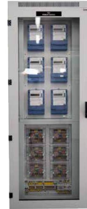
■ Szafa pomiarowa z zamontowaną płytą licznikową (uchylną i stałą)
