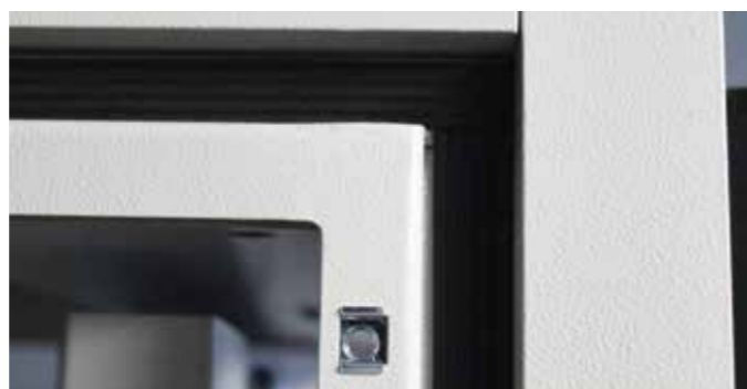
→ Uszczelnienie ścianki bocznej
