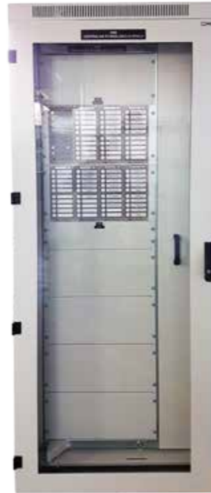
■ Szafa centralnej sygnalizacji stacji
