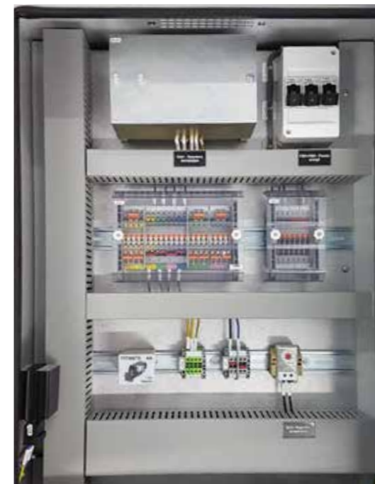
→ Wyposażenie szafki obwodów pomiarowych
