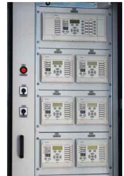
→ Zabezpieczenia pola 110kV zamontowane na ramie uchylnej
