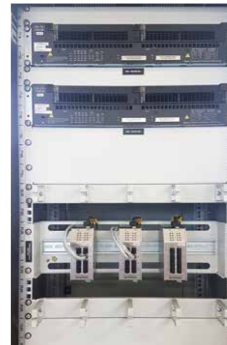
→ Elementy aktywne wyposażenia szafy SUT
