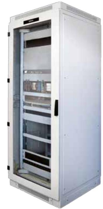
■ Szafa teletechniczna stacji 110kV
