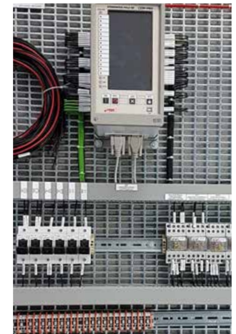
→ Płyta celki rozdzielni 15kV
