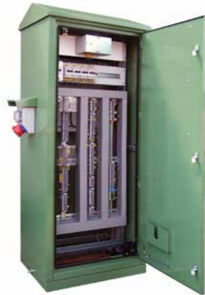
■ Szafa kablowa pola 110kV z układem pomiarowym
