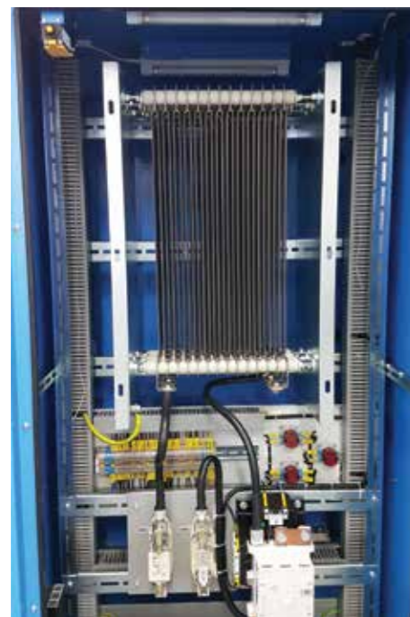
→ Montaż rezystora AWSC w szafie kablowej FS-1-1
