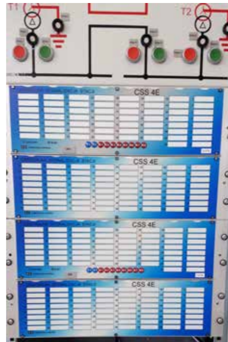
→ Sygnalizacja centralna stacji zamontowana w szafie sterownia lokalnego
