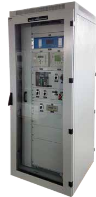
■ Szafa sterownicza pola transformatora
