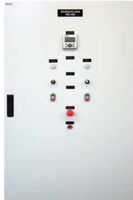
■ Rozdzielnia nn z układem SZR
