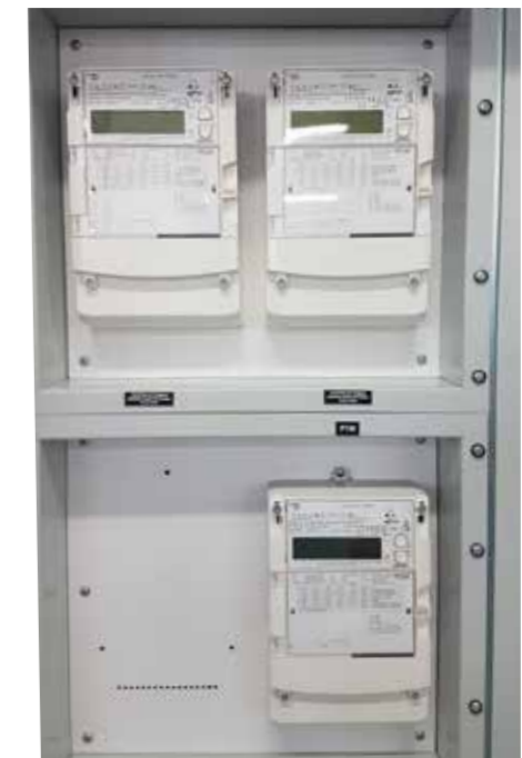
→ Wanna licznikowa z zamontowanymi licznikami
