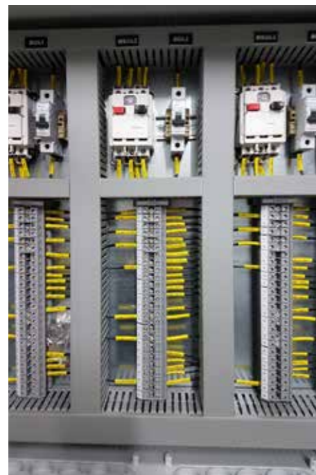
→ Wyposażenie rozdzielni obiektowej
