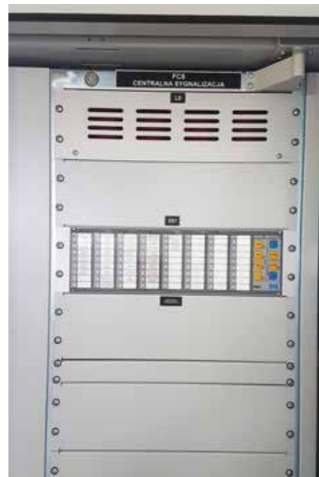
→ Sygnalizacja z układem akustycznym zamontowanym wewnątrz szafy
