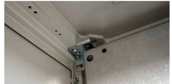
→ Elementy mocujące płyty montażowej
