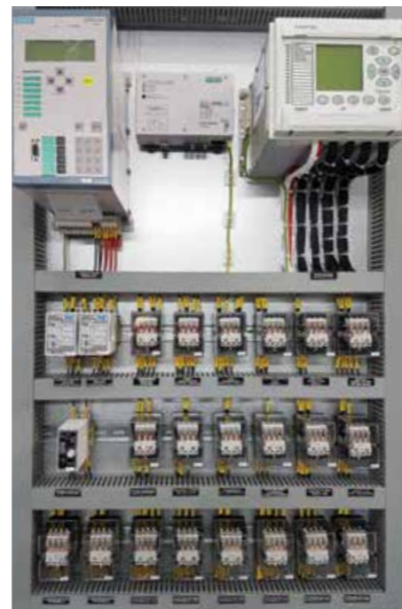
→ Zabezpieczenia cyfrowe zamontowane na płycie montażowej rozdzielni
