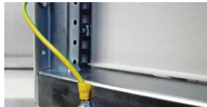
→ Uziemienie ramy uchylnej
