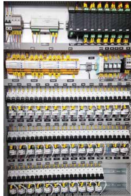
→ Sterownik i układ kontroli doziemienia szafy PW 220V DC
