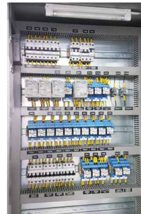
→ Montaż przełączników na płycie montażowej szafy
