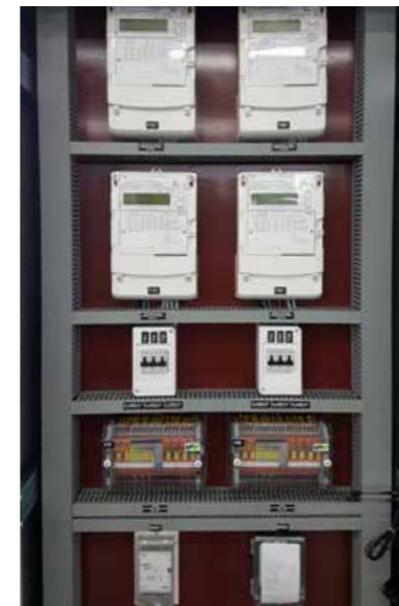
→ Montaż na płycie dielektrycznej stałej
