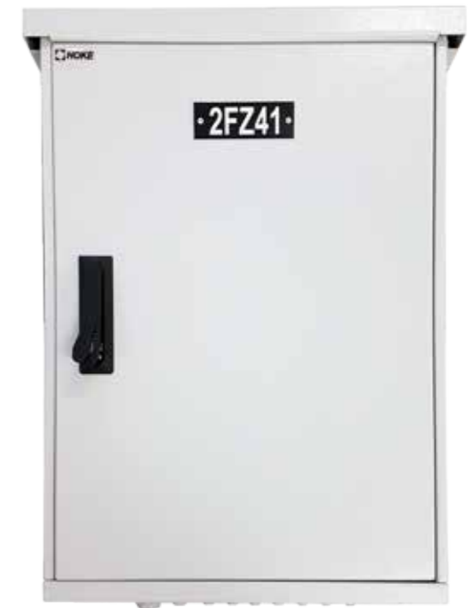
■ Szafka obwodów napięciowych stacji 220/110kV
