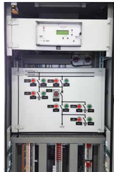
→ Płyty uchylne dla układu sterowania i sterownika wyłączników, zamontowane w szafie FS-1
